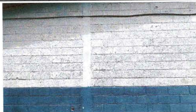
Foto 4: Se observa desprendimiento de pintura de las paredes.
