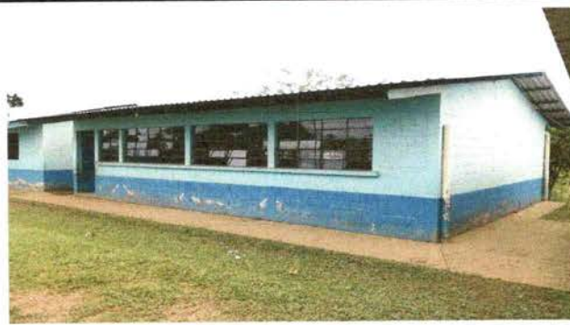
Foto 6: Se observa pintura en malas condiciones.
