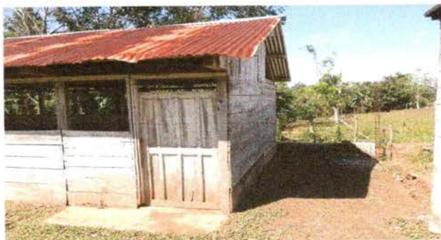
Foto 3: Se observa techo y pared en proceso.
